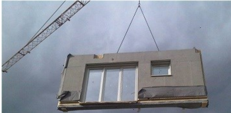
Utilizzo di pareti prefabbricate complete di serramenti
