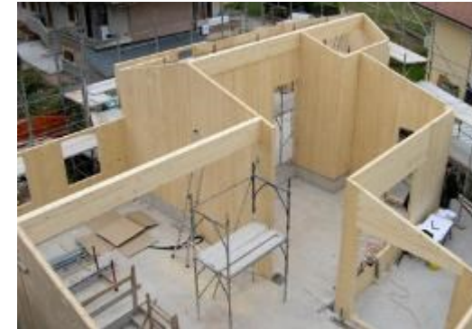
Telaio strutturale in legno lamellare con tamponamenti in pannelli di legno multistrato
